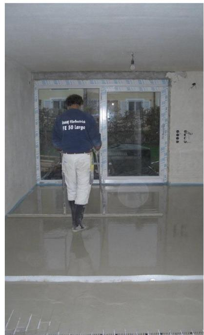
Nachbearbeitung der eingebrachten Nivelliermasse N 440 mittels Schwabbelstange
